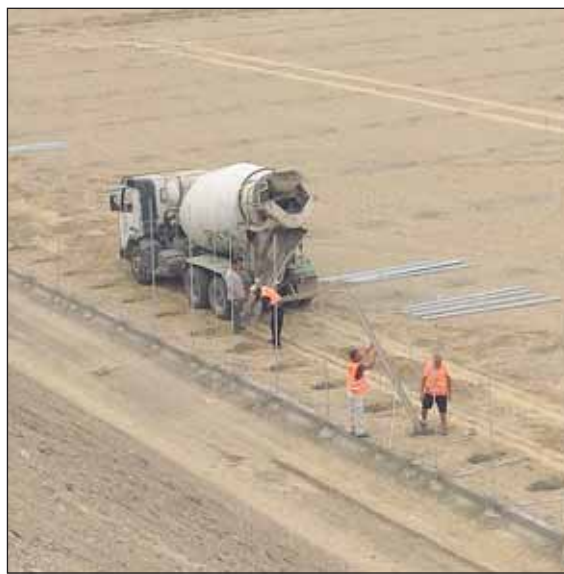
■ Construcción de un invernadero por parte de Techno Teonel.
