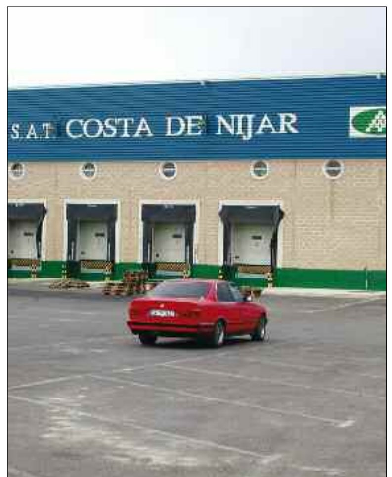
■ Instalaciones de Costa de Níjar. / FHALMERÍA
