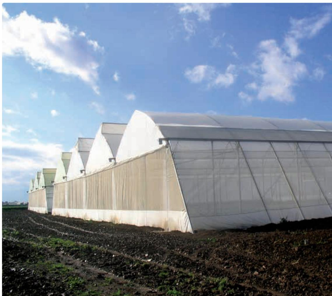
de alta resistencia a la tracción, estabilizados a los rayos UV y de peso ligero, con una densidad de hilos de 10x20 hilos/cm<sup>2</sup>.
