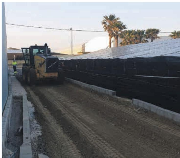
to de pavimentación del Camino de la Granja C-17 y del Tuerto C-18, en Pampanico, este se va a centrar en la construcción de una nueva rasante y la posterior pavimentación, logrando de esta manera una capa de rodadura cómoda y segura, además de ser capaz de drenar el agua superficial de la vía.
