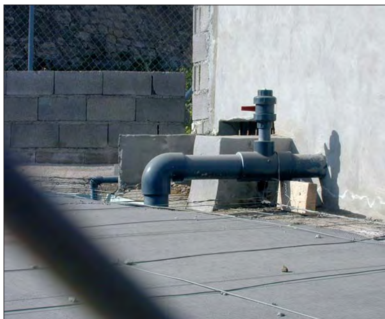
■ El agua es un bien escaso en la provincia de Almería. / FHALMERÍA
