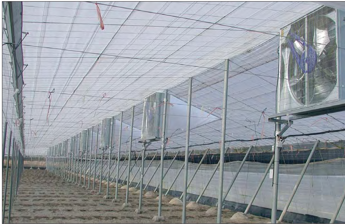
Los empresarios mexicanos se interesaron por todo lo relacionado con el cultivo bajo plástico. / FHALMERÍA
