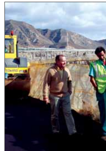
■ Vía rural asfaltada. / FHALMERÍA
