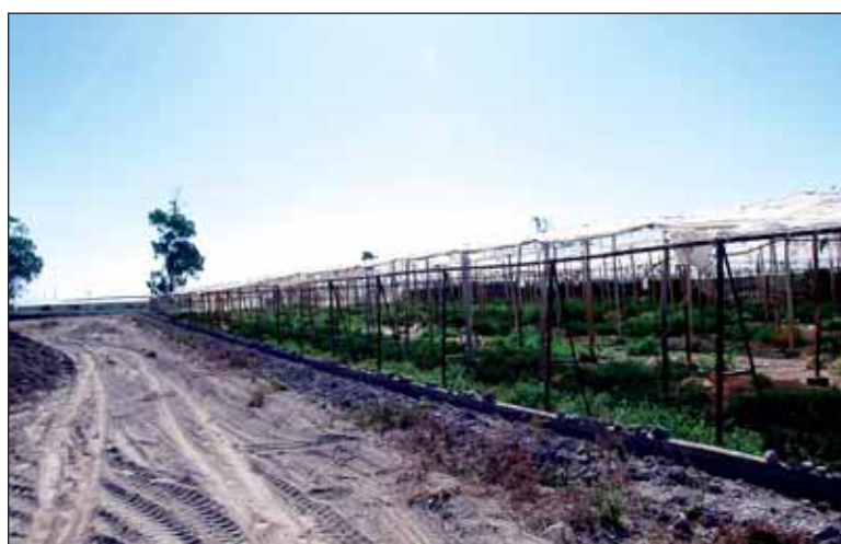
■ Ya se están reparando 80 kilómetros de caminos. / FHALMERÍA
