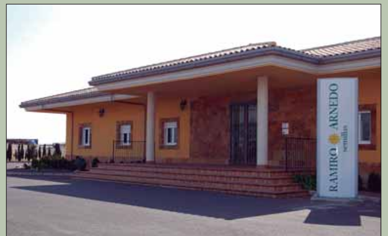
Instalaciones de Ramiro Arnedo en Almería. /FHALMERÍA
