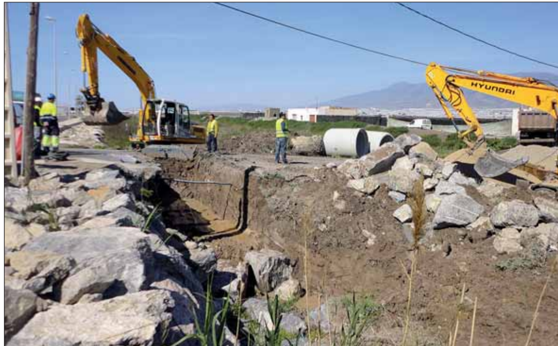
■ Las obras han comenzado ya en los cuatro cruces de la rambla del Cañuelo, en el término municipal roquetero. /FHALMERIA
