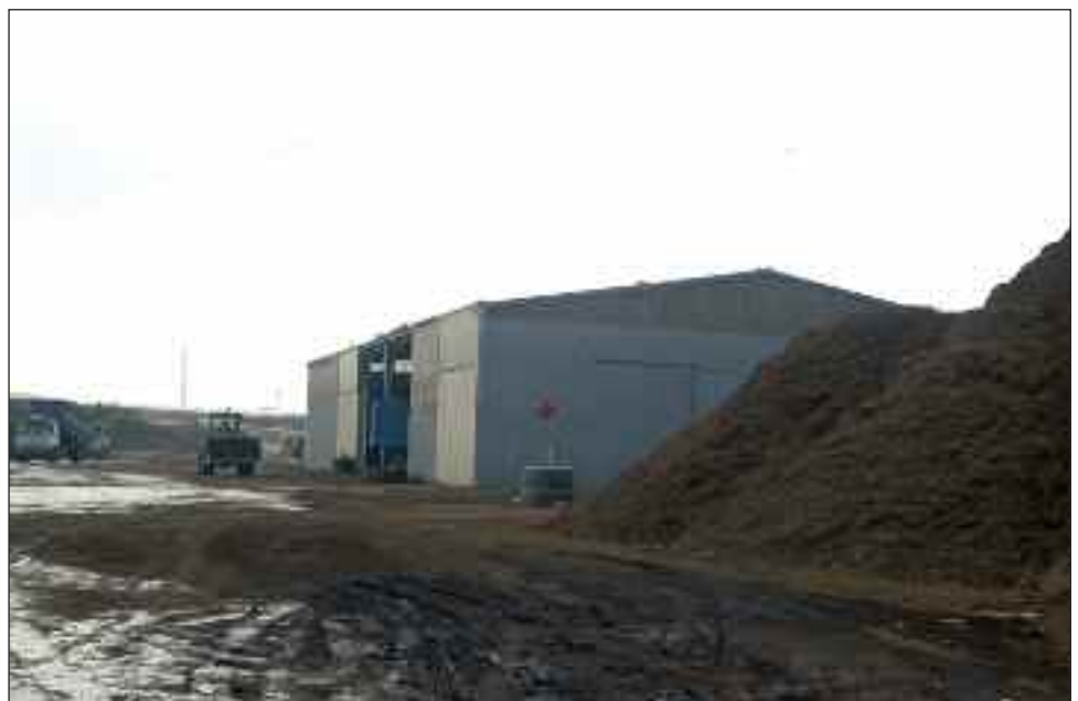
Ejido Medio Ambiente es la planta de reciclado agrícola con la que cuenta el municipio de El Ejido.
