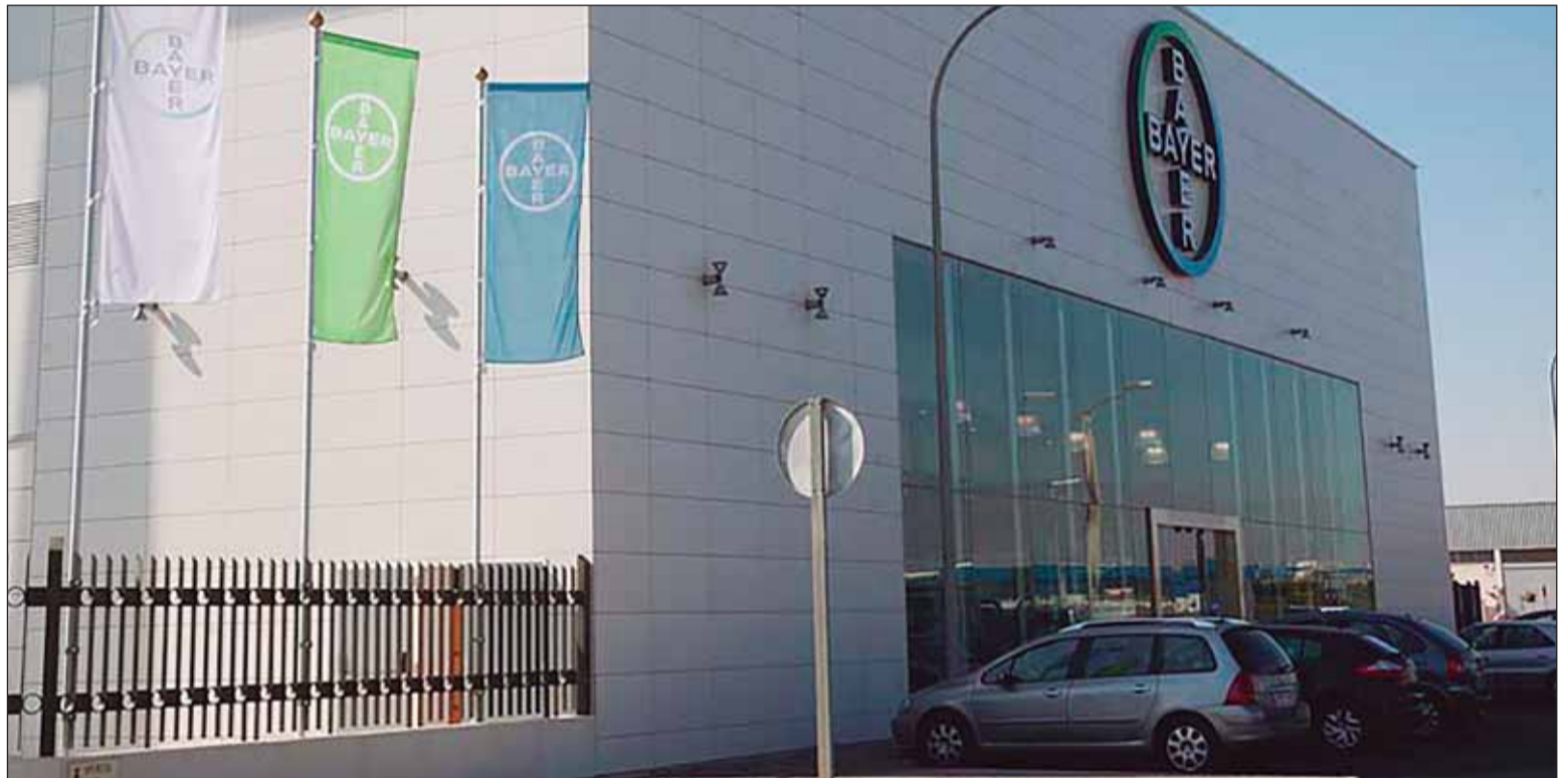
■ Impresionante aspecto de las nuevas instalaciones de Bayer Vegetable Seeds en el bulevar entre Santa María del Águila y El Ejido.
