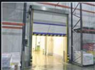
**INSTANT ROLL ECO:** Puerta rápida enrollable muy aislante para cámaras frigoríficas con temperatura positiva.
