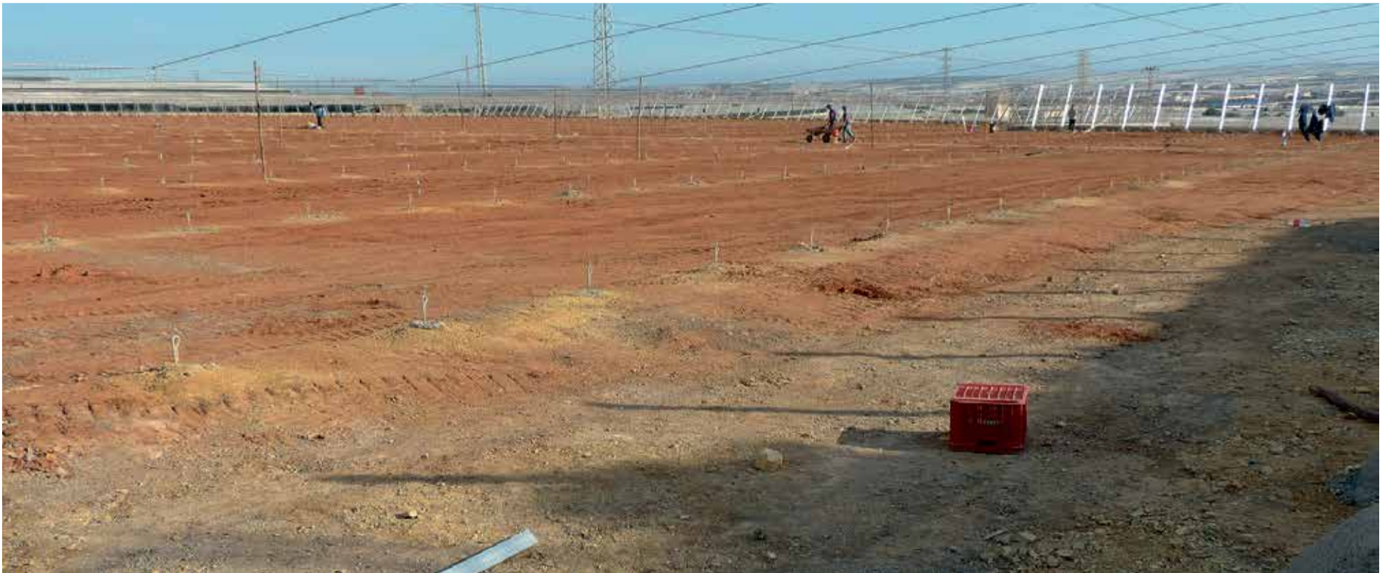
Construcción de una finca invernada este año en la zona norte del término municipal de El Ejido. /RAFA VILLEGAS
