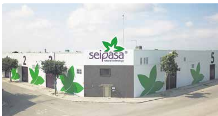
Fachada de las instalaciones de Seipasa, tras las obras de ampliación.
